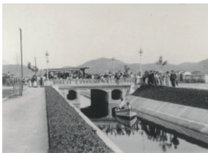
Figura 3. Inauguração do canal idealizado por Saturnino de Brito em 1907. Vista do canal 1, no trecho da atual Avenida Campos Sales, Bairro da Vila Nova. Fonte: José Marques Pereira. Acervo FAMS.
