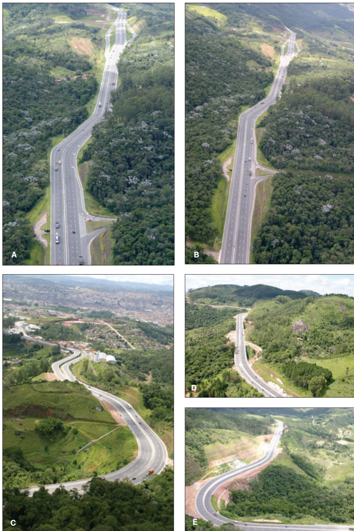
Figura 6. (A a E) Vista Aérea da Rodovia Mogi-Dutra. Fonte: Arquivo do Jornal “O Diário de Mogi”.
