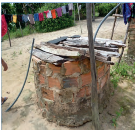
Figura 6 – Poço na comunidade Cumarú/ Igarapé-Açu/PA
