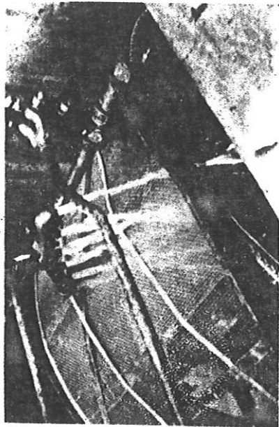
Figura 7.7 Grade Mecanizada junto a uma Pequena Captação
