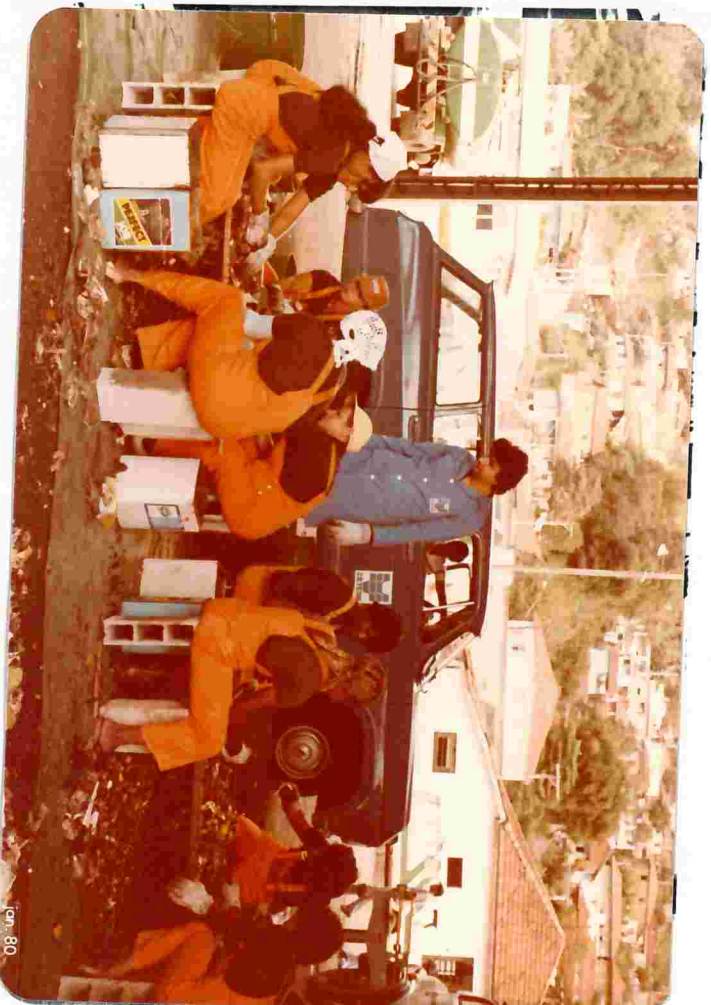
Foto I.2.5 - Peneiramento do lixo coletado, para melhor separação dos componentes.
