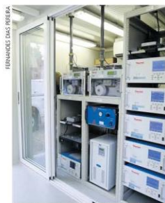
Estação - Parte do circuito de visitação
