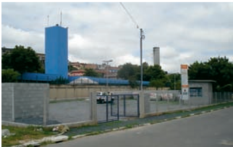
FIGURA 03-B. Instalação de PEV no Município de São Paulo
