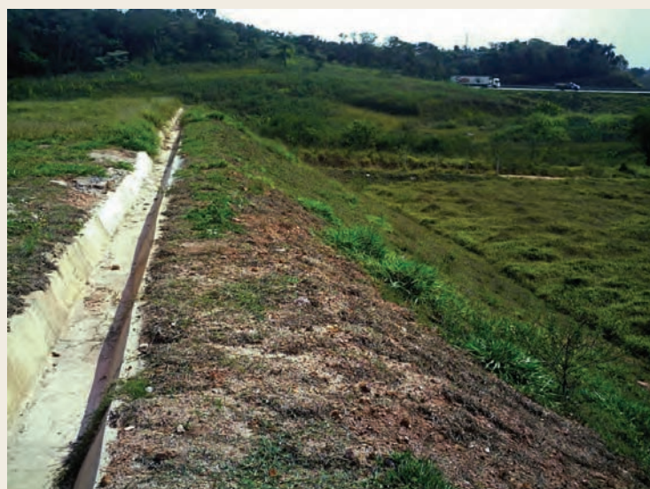
CANALETA E TALUDE EXISTENTE
