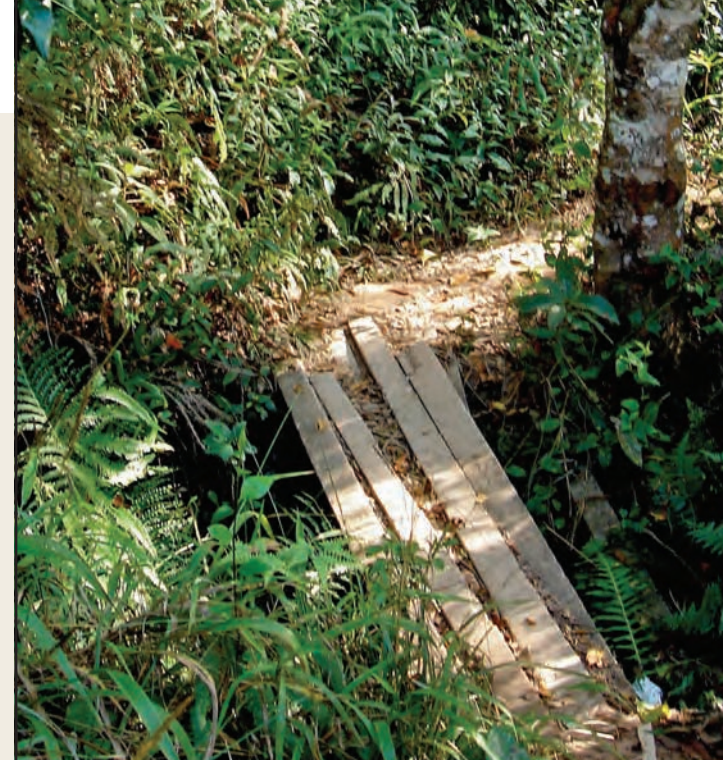
PASSAGEM DE CONCRETO QUE SERÁ SUBSTITUÍDA POR PASSARELA DE MADEIRA
