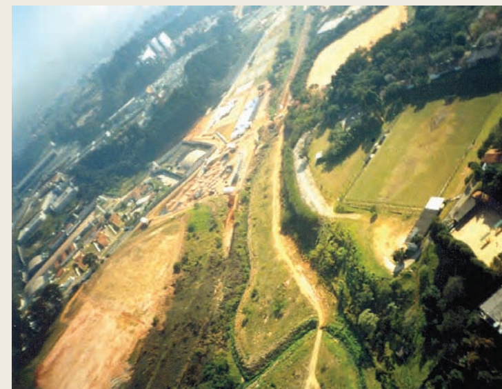
AVENIDA UM, ACESSO PARA PORTARIA LESTE.
