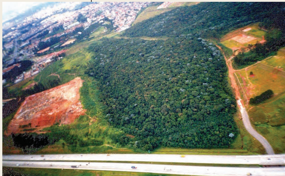
EM PRIMEIRO PLANO NA PARTE INFERIOR ESTÁ O RODOANEL, E À ESQUERDA UM ATERRAMENTO DENOMINADO ANACONDA, QUE PROVAVELMENTE INVADIU PARTE DA DIVISA DO PARQUE. NA PORÇÃO CENTRAL DA FOTO ESTÁ A MATA EXISTENTE DO PARQUE TIZO A SER PRESERVADA
