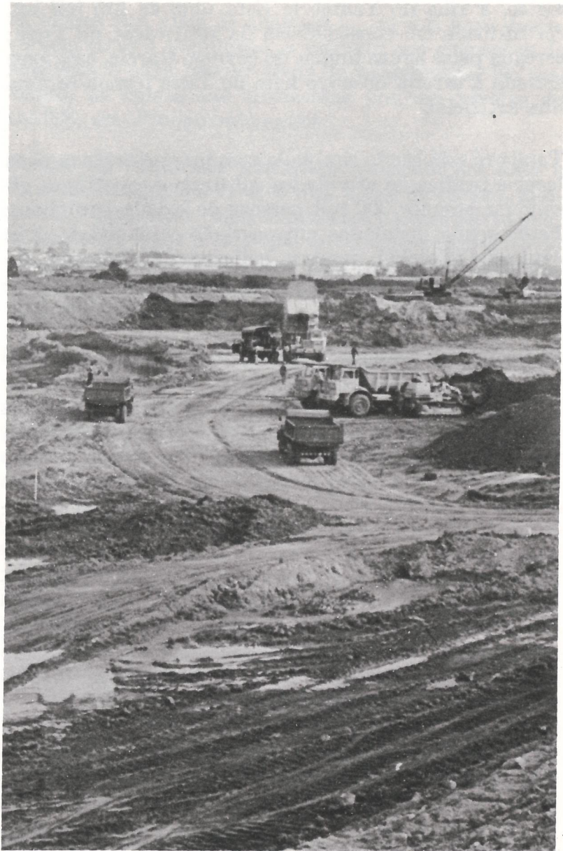
No Rio Tietê, obras contra enchentes, e o Parque Ecológico.
