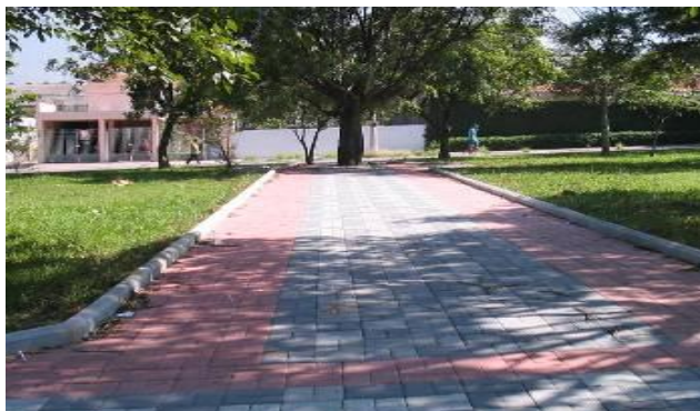
Reconstrução de passeios
