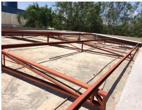
Cobertura do novo laboratório
