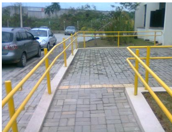
Nova rampa de acesso
