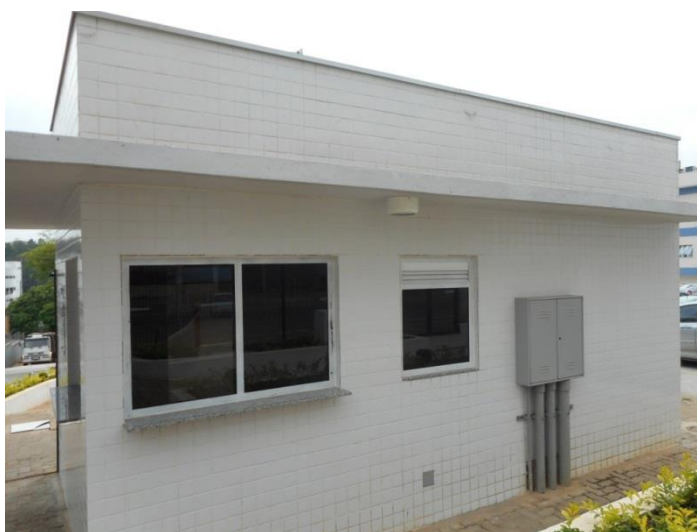
Reforma e blindagem da guarita
