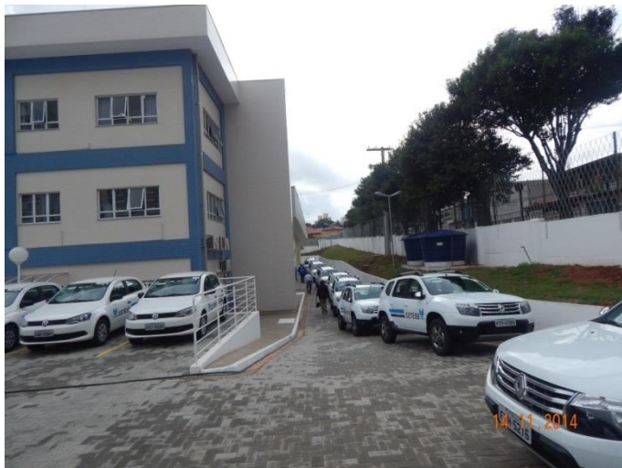
Pintura muros e guias de calçada
