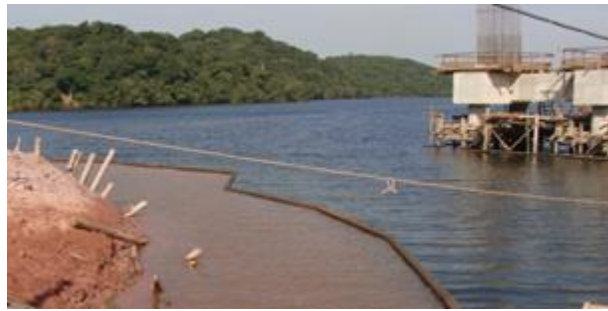
Figura 24 - Uso de barreira para contenção de sedimentos em obras rodoviárias
