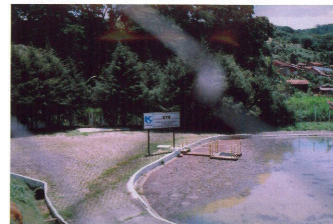
Estação de Tratamento de Esgotos em Sto. Antônio do Pinhal
