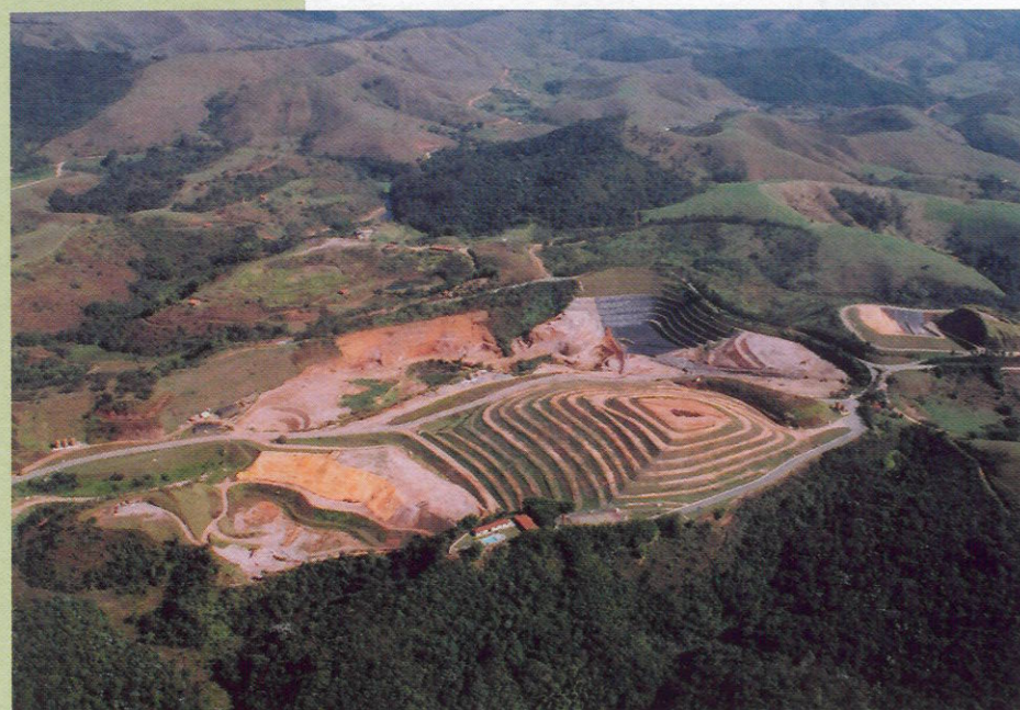
Aterro Sanitário, SASA em Tremembé
