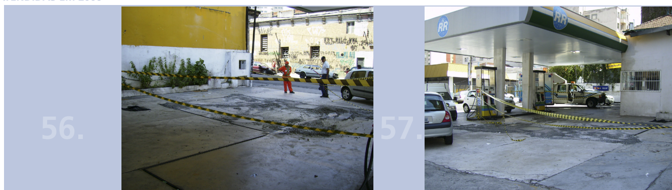
Figuras 56 e 57 – Posto desativado onde foi detectado risco de explosividade no Bairro de Campos Elíseos.
