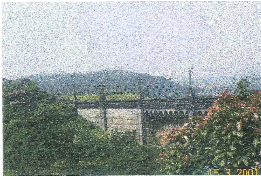
Figura 3 – Vista posterior da Barragem de Pedras. Área próxima ao ponto de monitoramento.
