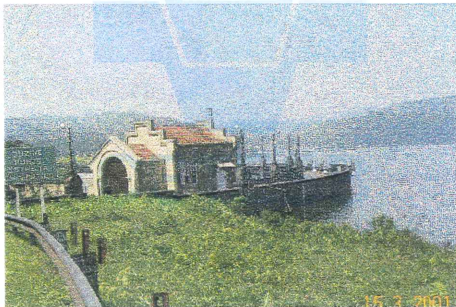
Figura 2 – Vista anterior da Barragem de Pedras. Área próxima ao ponto de monitoramento.
