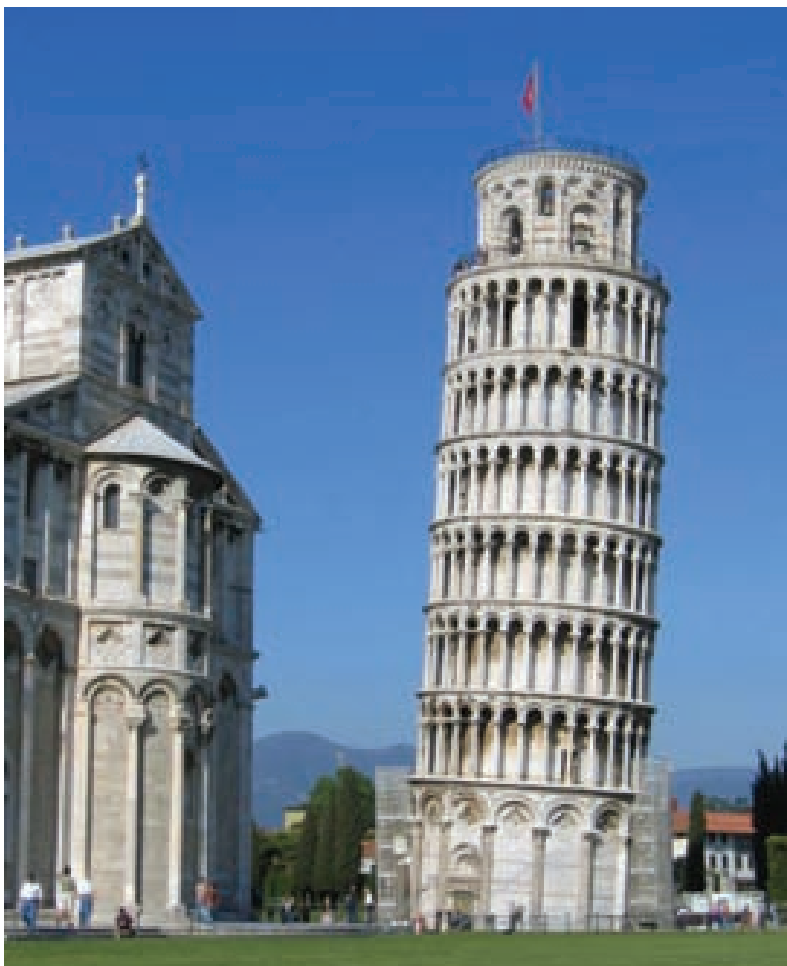
Torre de Pisa, Itália. Desde que começou a ser construída, no ano de 1173, sofre inclinação pelo excesso de peso em sedimento pouco compactado (Maio de 2004). Foto: Alkarex Malin Åger.
