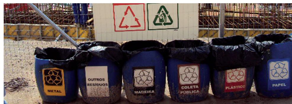
Separação de materiais recicláveis no canteiro
