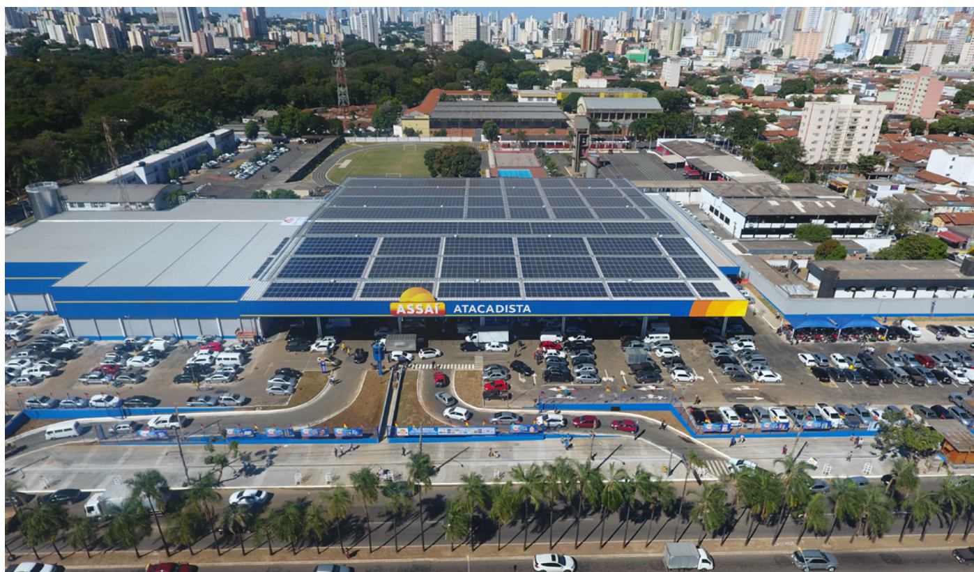
Vista panorâmica, com a usina solar em destaque no telhado da loja Independência, em Goiânia – GO.
