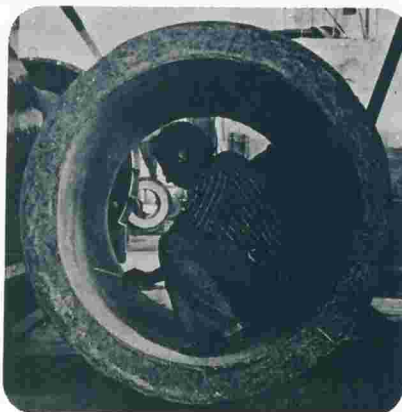
Inspeção visual de um tubo de concreto protendido.
