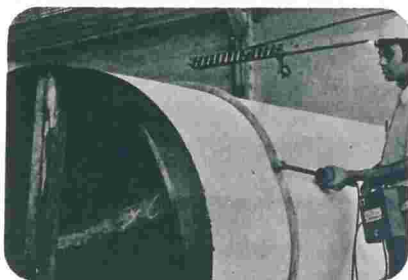
Verificação da continuidade do revestimento, em tubo de aço com a utilização do Holiday Detector.
