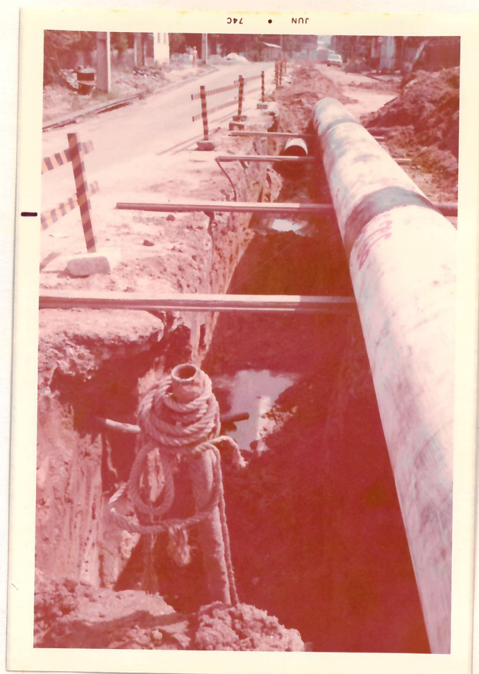
34 - Tubulação pronta para ser descida, aguardando limpeza da vala e colocação do grade.
