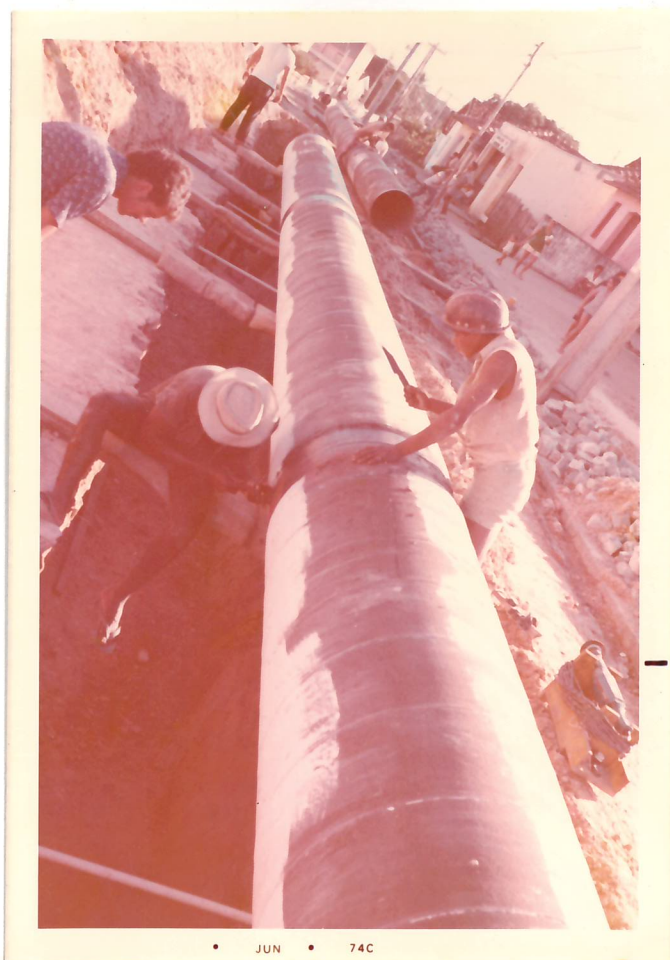
48 - Chicote sendo feita a limpeza da junta para em seguida ser feito o revestimen to .
