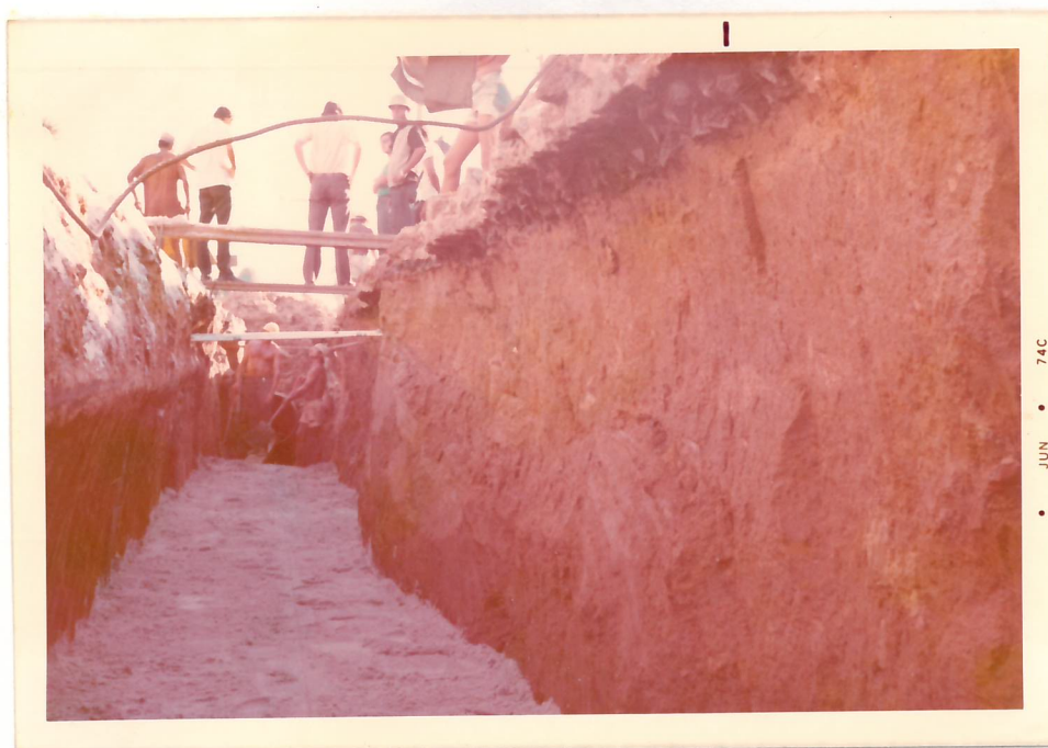
42 - Vala com grade pronto para a descida da tubulação.
