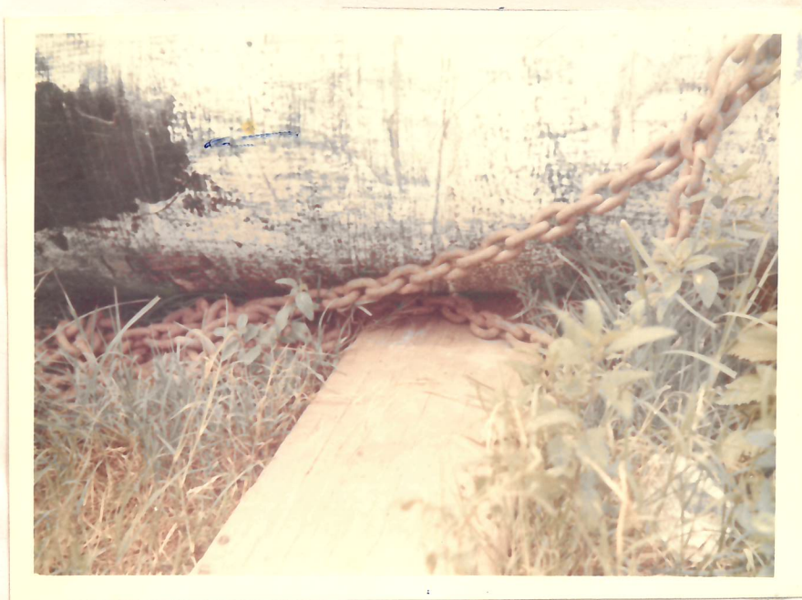
1 - Tubo apoiado sobre corrente, e sem berço de proteção no revestimento. Note-se o detalhe do reparo.
