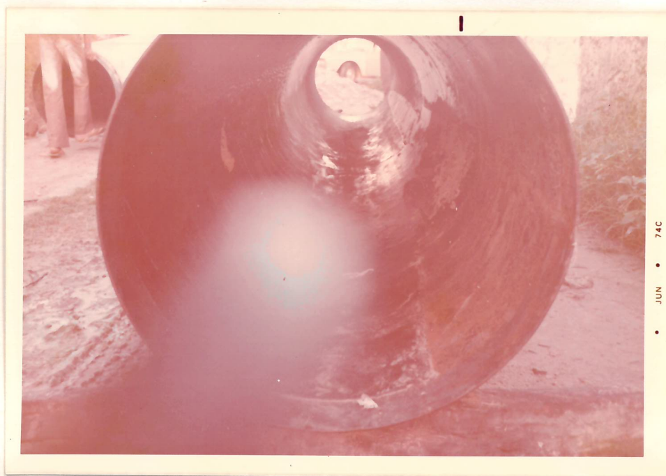
28 - Tubo destruído por fogo, durante a soldagem da junta, por esquecimento de uma lata com gasolina usada para a limpeza, em seu interior.
