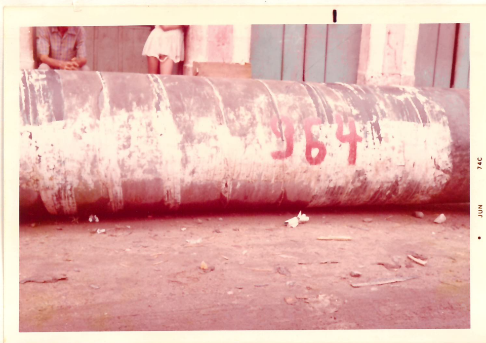
27 - Tubo apoiado sobre o pavimento.
