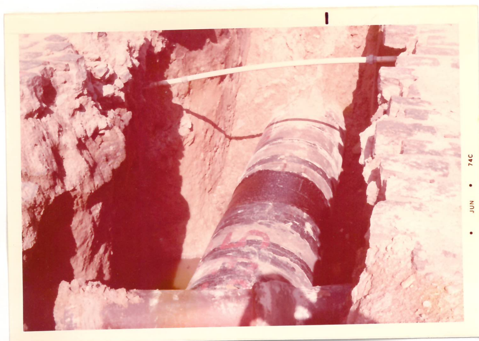
39 - Tubo com a junta imprimada aguardando re vestimento externo.
