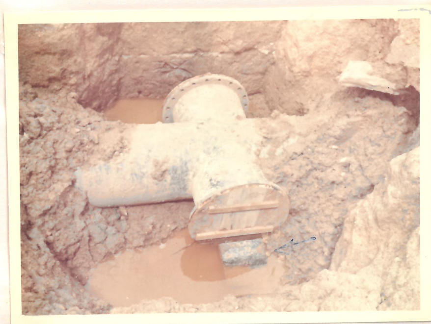
II - Cruzeta aguardando a colocação dos flanges para ser reaterrada.
