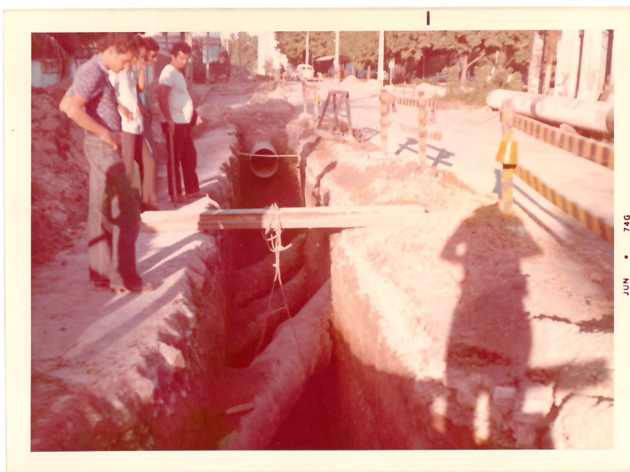
36 - Cruzamento com linhas de distribuição de diversos diâmetros, aguardando solução.
