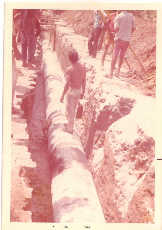
44 - Chicote descido corretamente dentro da vala.
