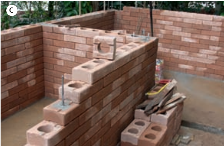
FIGURA 21 – (A) OS PISOS INTERTRAVADOS EVITAM A IMPERMEABILIZAÇÃO DO SOLO, POIS PERMITEM O ESCOAMENTO DAS ÁGUAS. (B) E (C) TIJOLO DE SOLO-CIMENTO FABRICADO COM 95% DE TERRA E 5% DE CIMENTO QUE REQUER POUCA ARGAMASSA (SISTEMA DE ENCAIXE) E GERA MENOS RESÍDUOS NA OBRA. FONTE: ACERVO SMA.
