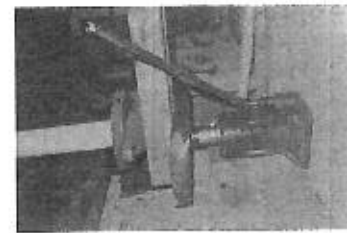
Fig. 4.65-B — Vedação das extremidades.
