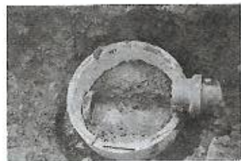
Fig. 5.5-C — Assentamento do 1.º anel e concretagem das almofadas.
