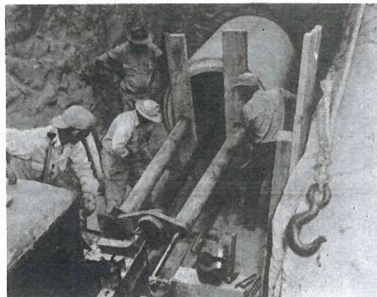
Fig. 3.18-B — Cravação de um tubo de 110 cm.
