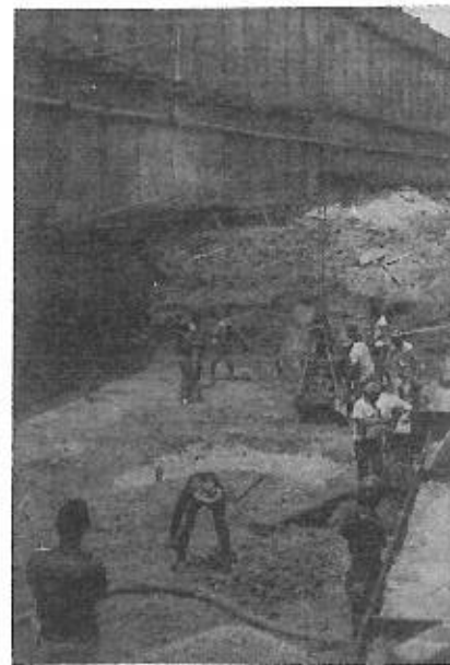
Fig. 3.63-C — Cortina com 3 carreiras das longarinas (espaçamento de 4 a 5 m) e tirantes espaçadas de aproximadamente 2 m.
