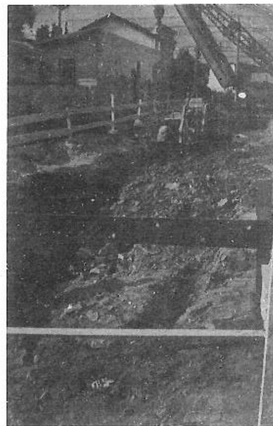
Fig. 3.67 — Reaterro com solo arenoso de coesão moderada.
