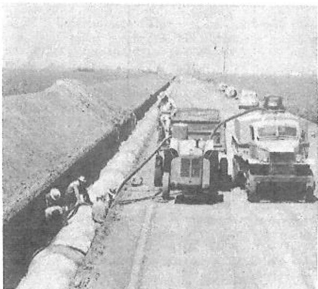
Fig. 3.66 — Compactação por irrigação e vibração, observando-se o caminhão-pipa para colocação de água em excesso no reaterro.
