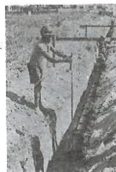
Fig. 4.7 — Assentamento de tubo cerâmico.
