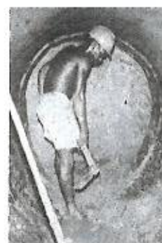
Fig. 3.20-G — Escavação do material frente ao tubo-guia.
