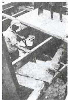
Fig. 3.2-A — Escavação e duas plataformas de trabalho; observe-se a pá de bico para cavar e a quadrada para "tombar".
