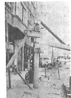
Fig. 3.64-B — Escoramento de poste junto à cava.
