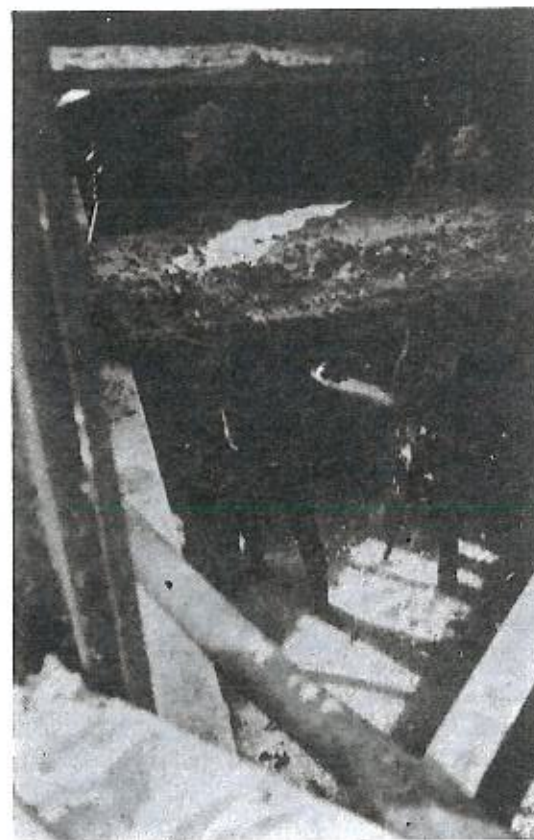
Fig. 3.25 — Cravação por jato d'água.
