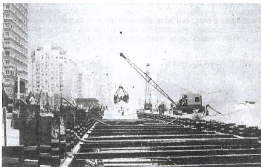
Fig. 3.7 — Escavadeira equipada com "clamshell".
