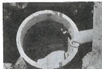
Fig. 5.5-D — Assentamento do 3.º anel, almofadas prontas e degraus de ferro fundido.
