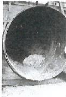
Fig. 3.20-J — Ponta do tubulão na câmara de saída.
