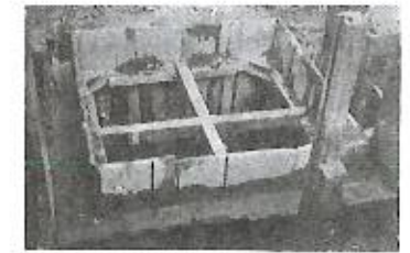
Fig. 5.8-B — Concretagem da câmara de trabalho.
