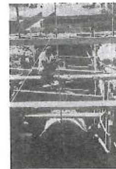
Fig. 4.8 — Assentamento de tubo de concreto.
