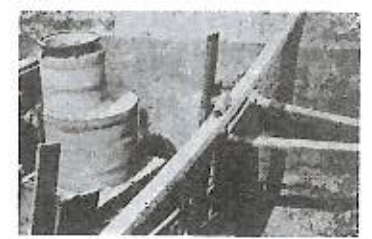
Fig. 5.8-D — Poço completado com anéis pré-moldados.
