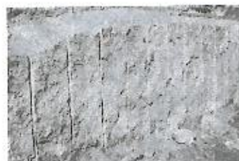
Fig. 3.14-C — Corte no plano limite de escavação.
