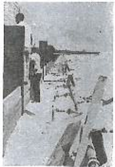
Fig. 3.26-A — 1.º estágio de ponteiros filtrantes pela parte externa da vala.
