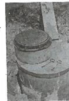
Fig. 5.5-H — Posicionamento do tampão de F.F. tipo MD, aparecendo as "chaves" de abrir tampão.
