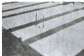
Fig. 2.5-B — Piquete de nivelamento e espessura do "radier".
