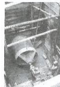
Fig. 3.20-F — Cravação do tubulão de aço, observando-se a câmara de trabalho.
