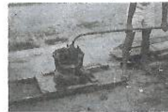
Fig. 3.23-C — Bomba de diafragma, "tipo sapo", manual.
