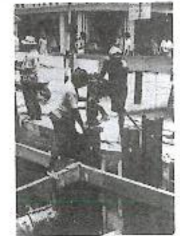
Fig. 4.23-B — Cravação de estaca-prancha.
