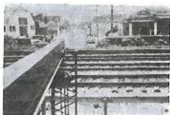
Fig. 3.20-A — Linha férrea, a ser transposta em túnel.
