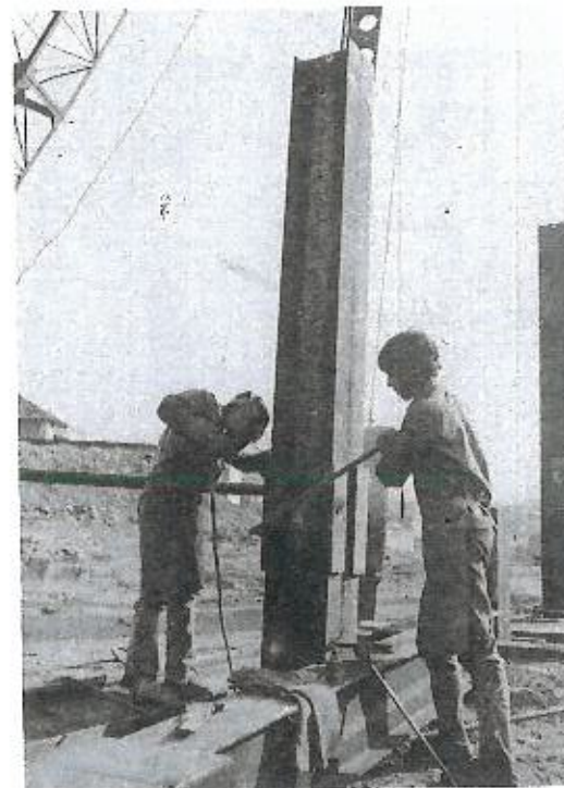
Fig. 3.42 — Estaca composta de perfis I.
