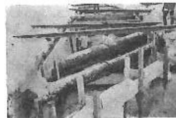
Fig. 3.64-A — Escoramento de tubulações que cortam a vala.
