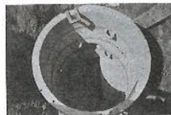
Fig. 5.5-E — Assentamento do 4.º anel, arremate da ponta do tubo de chegada, degraus de ferro fundido.
