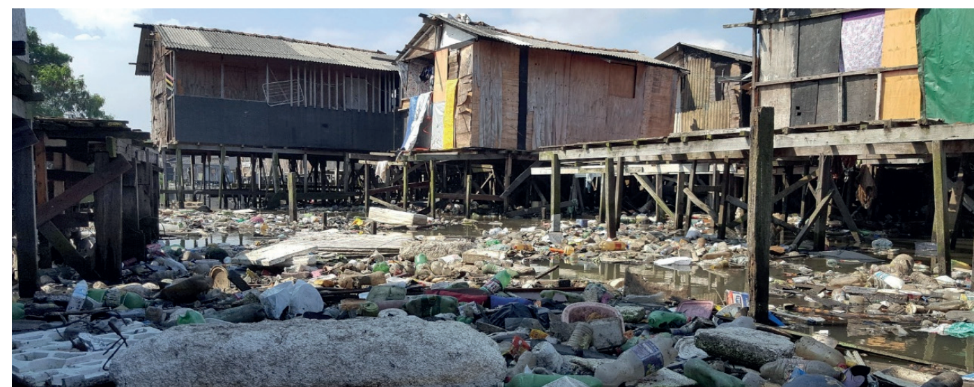
Figura 12. Moradias de palafitas em meio aos resíduos sólidos e esgoto no Dique da Vila Gilda. Foto: William R. Schepis.
