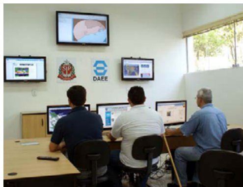
Figura 12.12 - Sala de Situação - DAEE/Registro.
