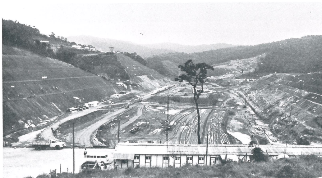
Obras de preparação do local para a construção da estação de tratamento de água.
