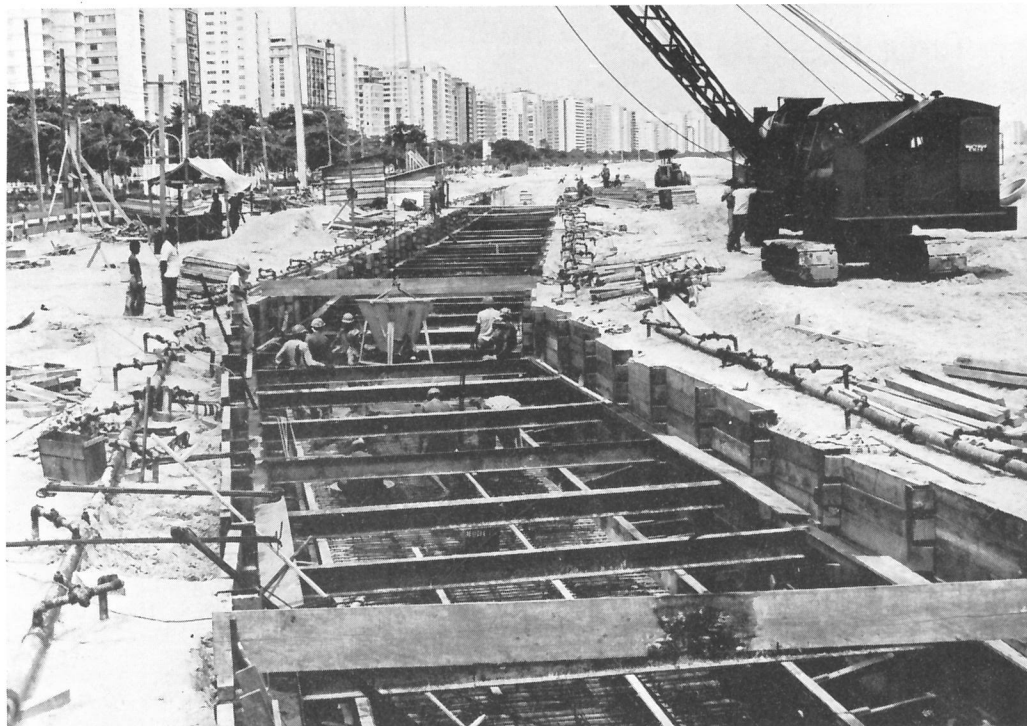
Primeira etapa das obras do grande Interceptor Oceânico, em execução, ao longo da Praia de Santos, obedecendo ao Plano Diretor de Esgotos de Santos e São Vicente, recentemente elaborado.
