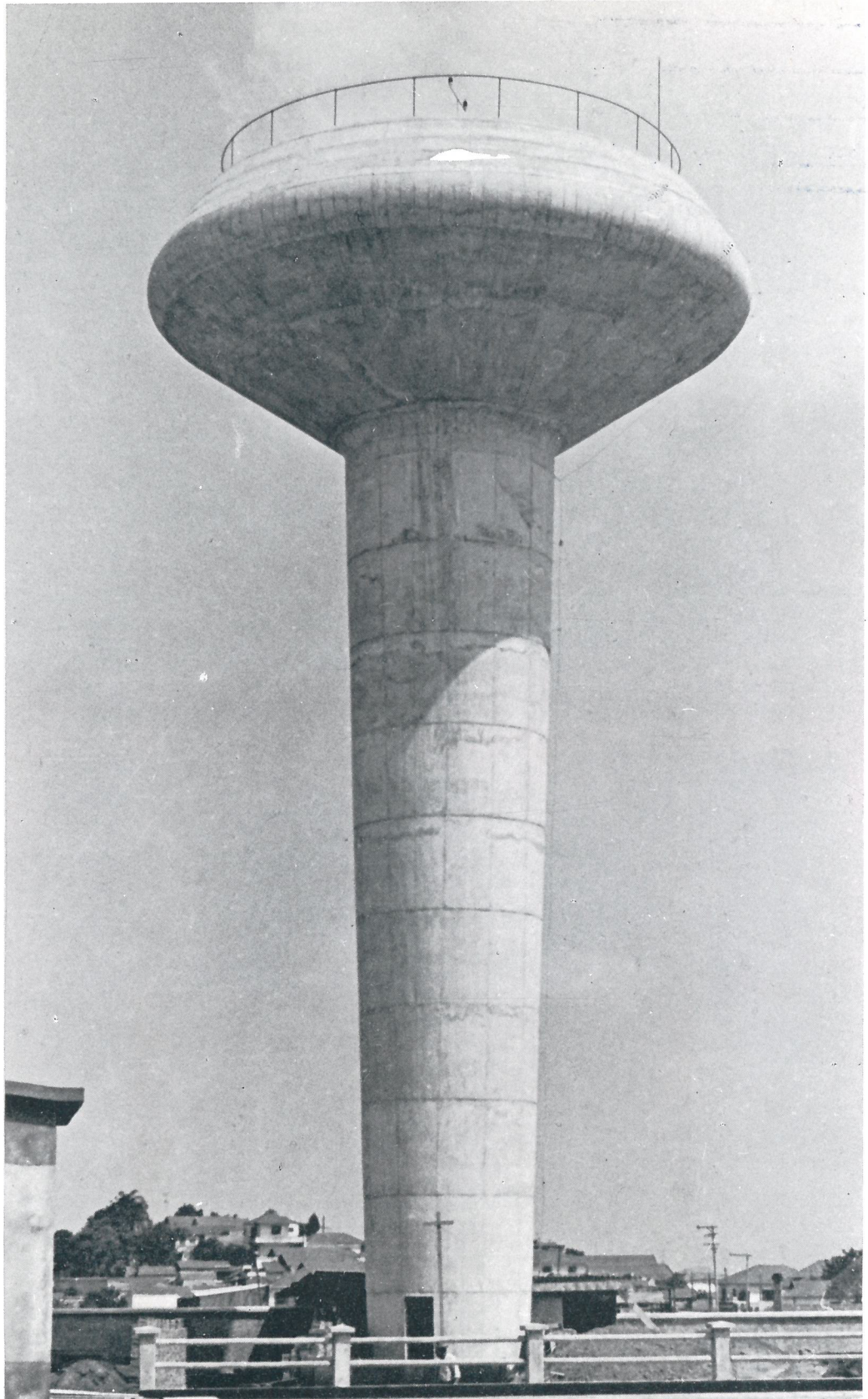
Tôrre de Vila Jaguará, com capacidade para 500.000 litros, um dos reservatórios recentemente construídos dentro do plano de expansão do sistema distribuidor de água na área da Capital.
