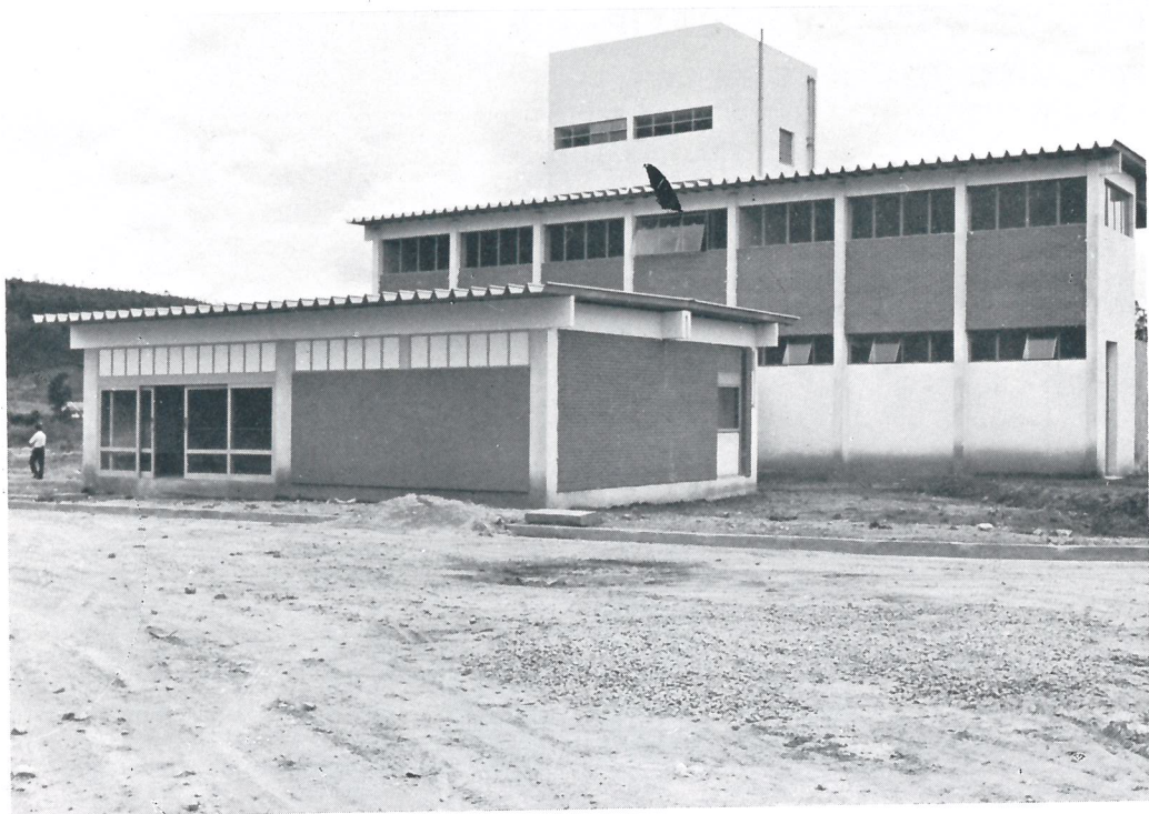
Estação de tratamento de água e casa de bombas recém-construídas em Campo Limpo. É a primeira obra concluída com financiamento do convênio FESB-BNH-BANESPA.
