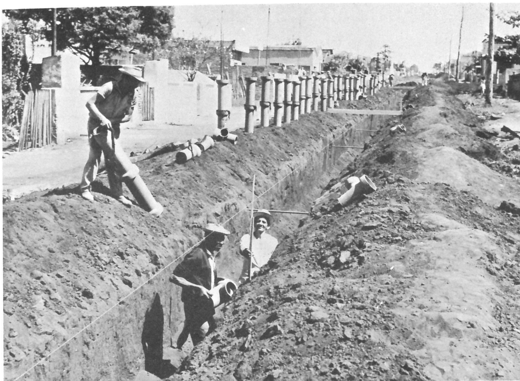
Construção de rede coletora de esgotos em Ribeirão Preto com recursos financiados pela Caixa Econômica Estadual e fiscalização do FESB.
