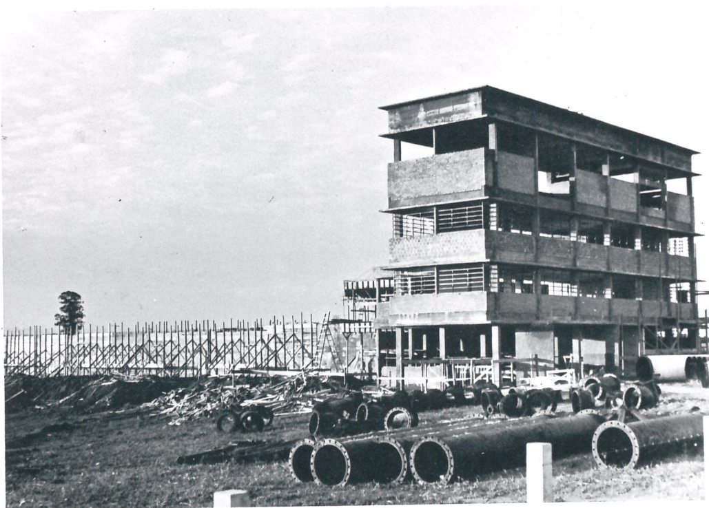
Nova estação de tratamento de água que está sendo construída em Marília com financiamento estadual e fiscalização técnica do FESB, para atendimento de uma população de 70.000 habitantes.
