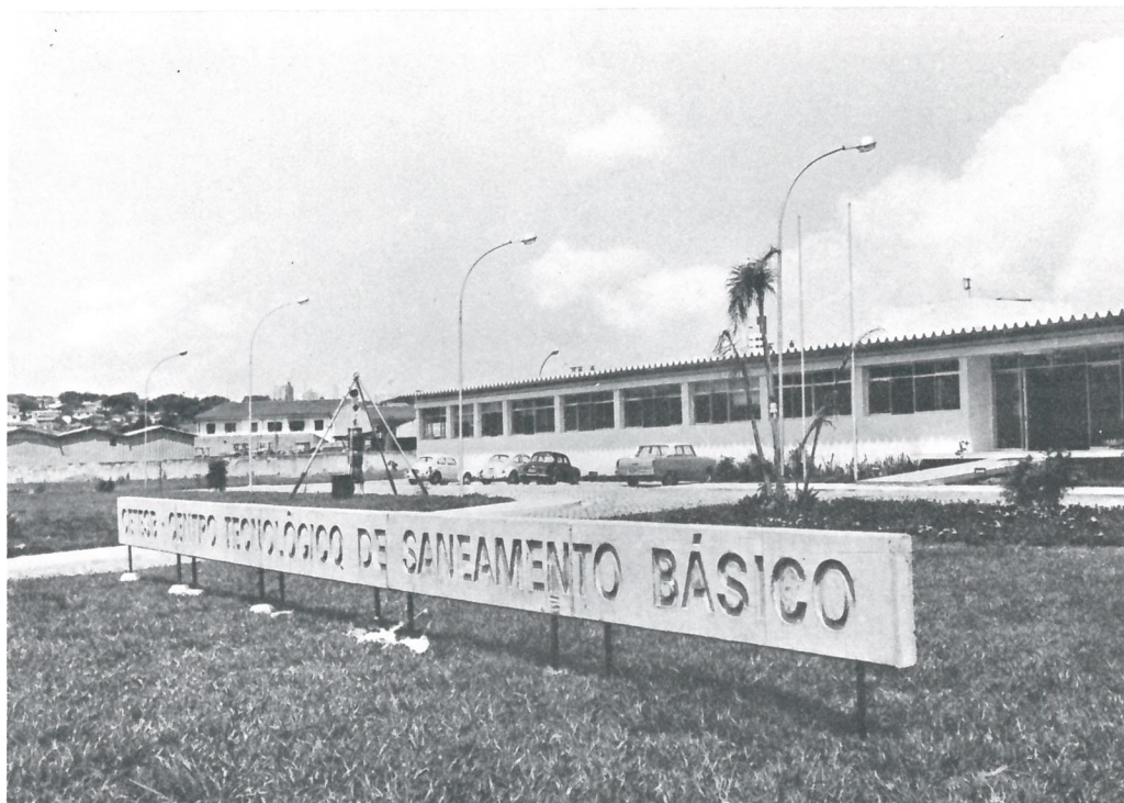
No Centro Tecnológico de Saneamento Básico — CETESB, localizam-se os laboratórios para exame e controle de águas de abastecimento e residuárias. Reúne ainda setores especializados para treinamento de pessoal, estudo de normas e especificações, ensaios para recebimento de materiais e pesquisas tecnológicas no campo do saneamento básico.
