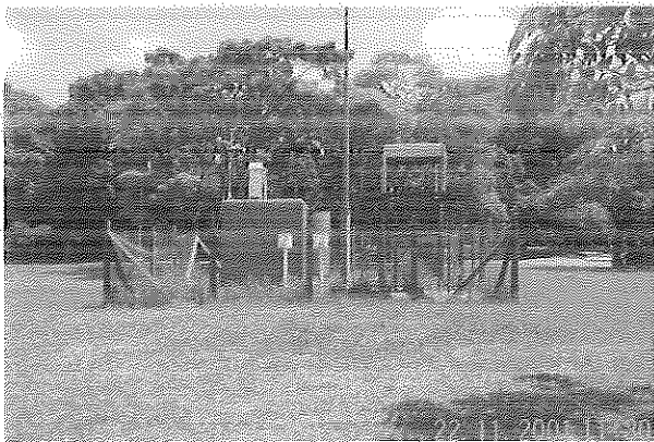
FIGURA 1 - Vista de sudeste para noroeste da estação.
