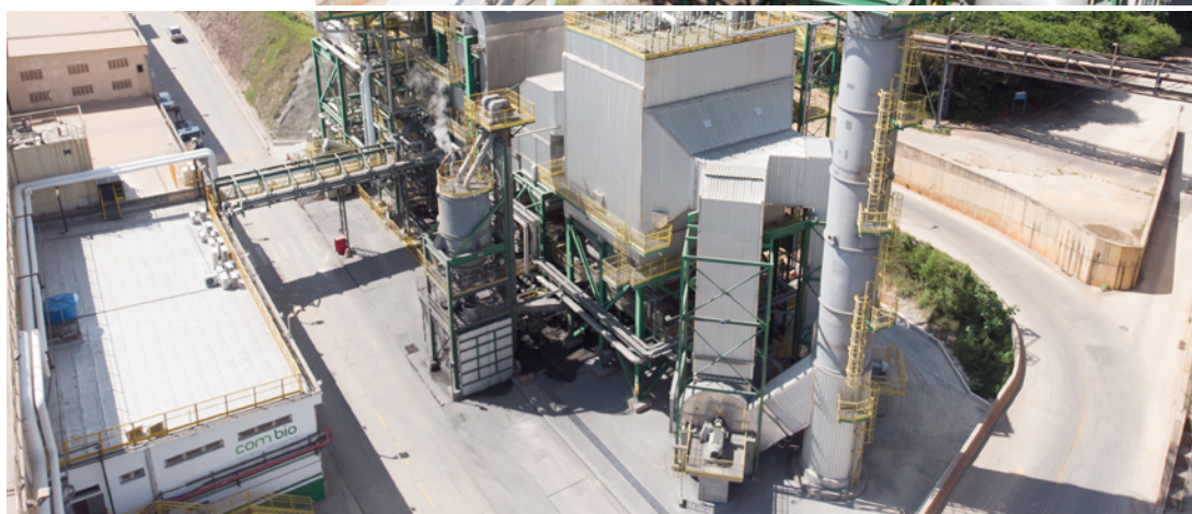
Caldeira Biomassa instalada na Refinaria de Alumina da CBA (Alumínio/SP).
