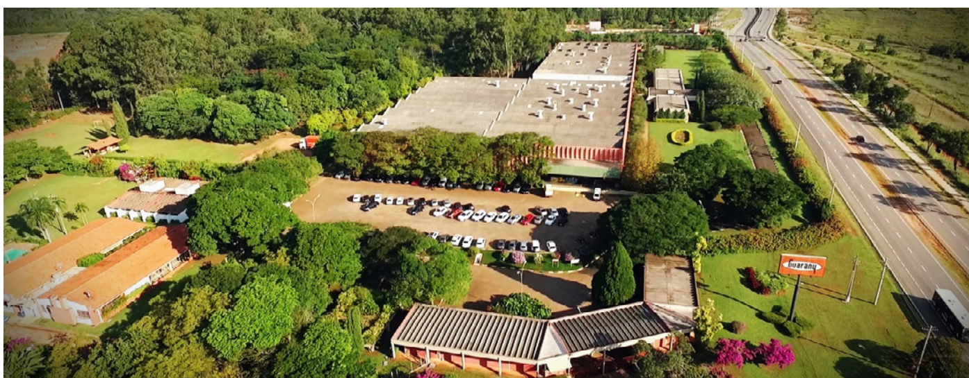
Planta industrial da Guarany em Itu.
