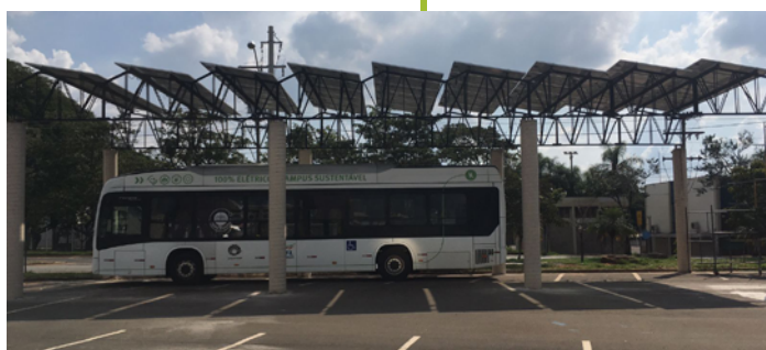
Carport após a conclusão da obra.
