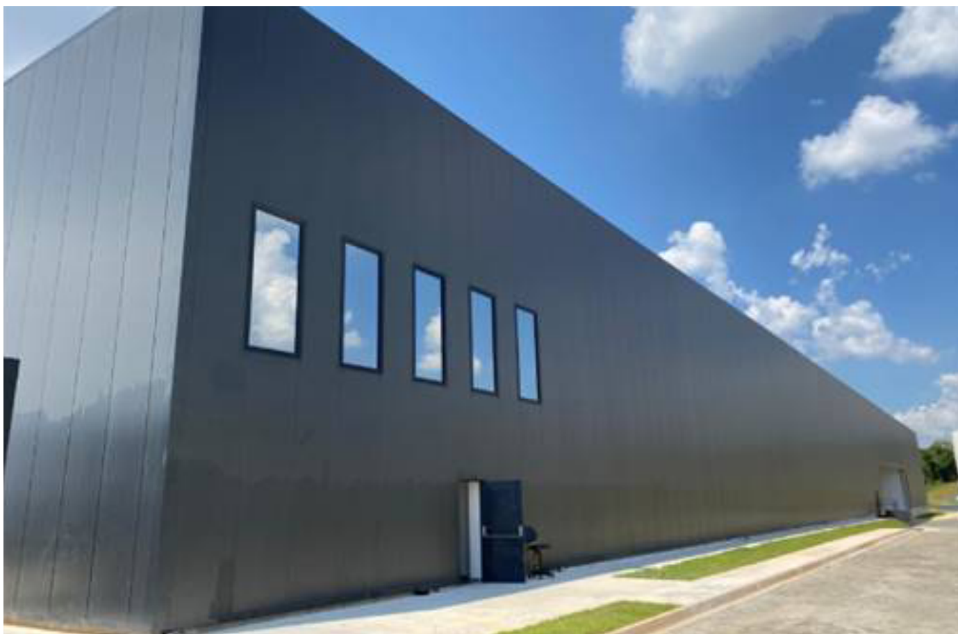
Galpão Industrial da Parafix, em Vinhedo, com aplicação de soluções Steligence.
