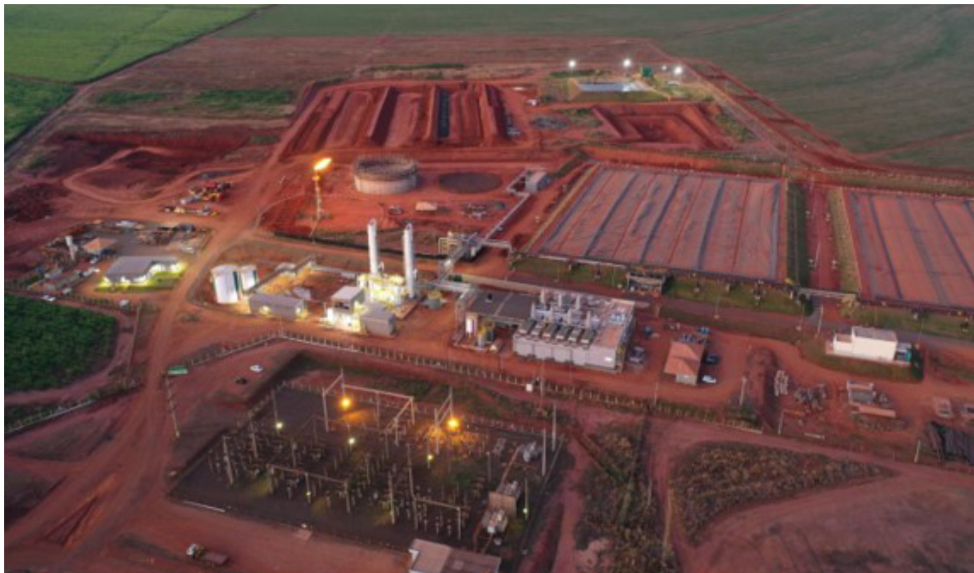
Foto aérea da planta de biogás na Usina Bonfim.
