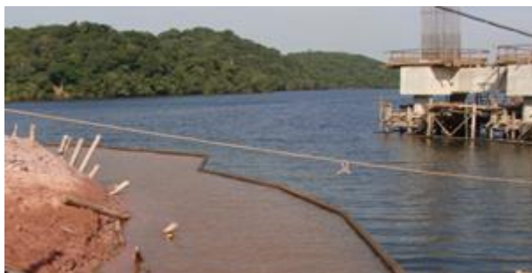
Figura 19 - Uso de barreira para contenção de sedimentos em obras rodoviárias
