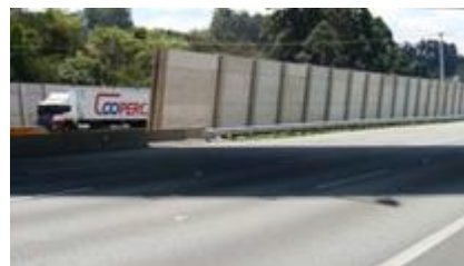
Figura 20- Barreira de ruído em rodovia
