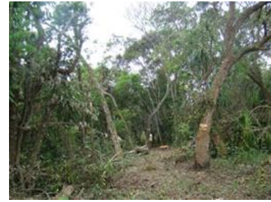
Figura 22 - Abertura de trilha (picada) para implantação de torres
