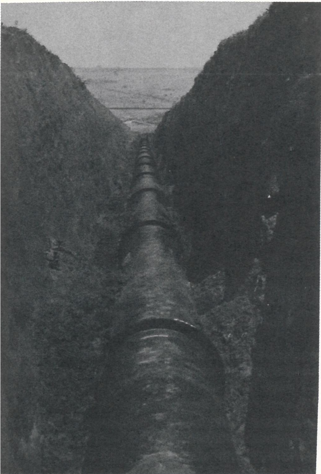
Adutora de água para Marília, com diâmetro de 500 mm e comprimento de 3.650 m.
