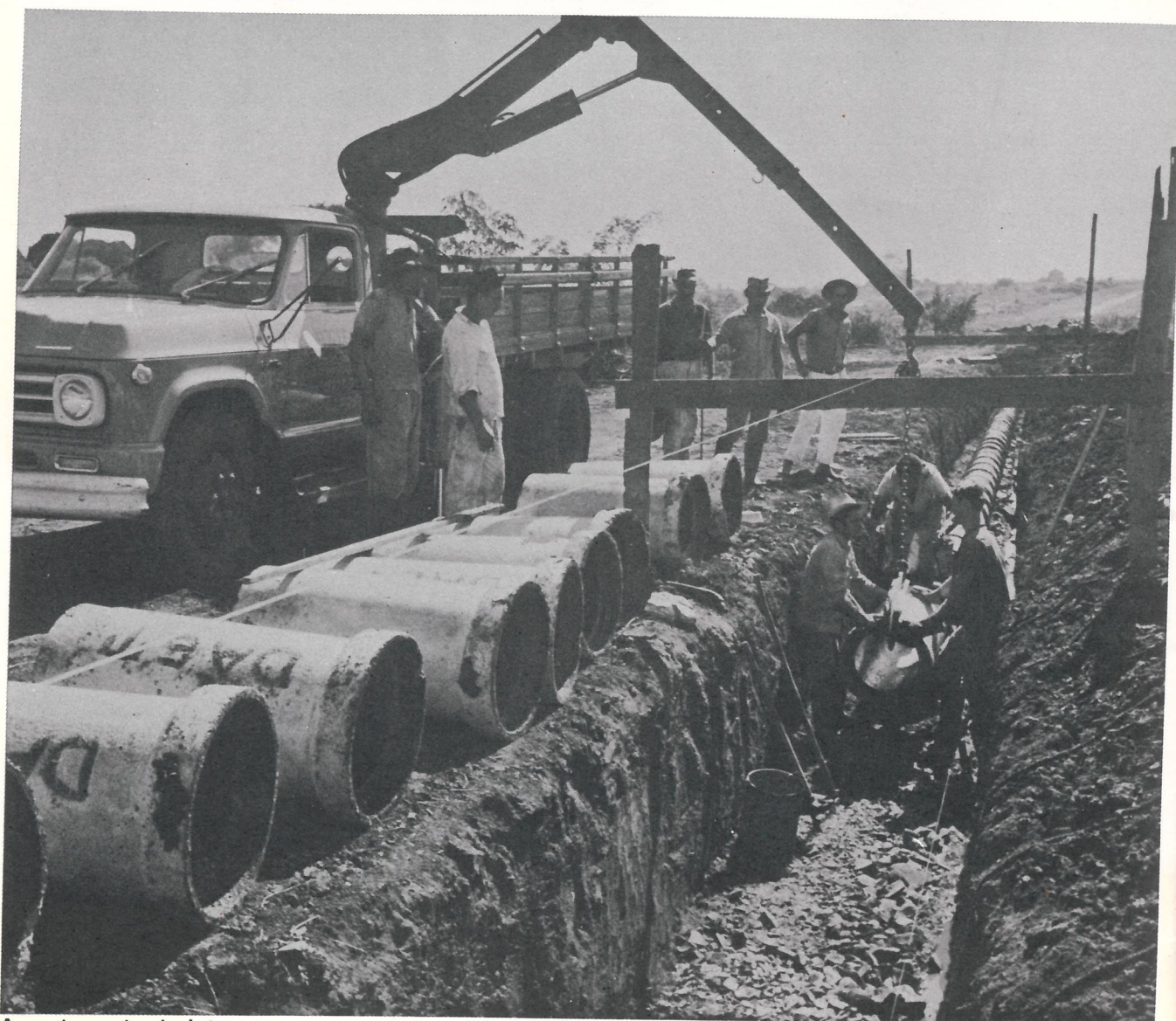
Assentamento de interceptor de esgotos, em Ribeirão Preto.
