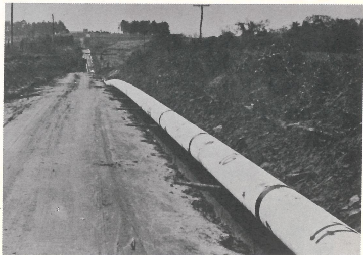
Adutora de Água de Bauru, — montagem e assentamento. Diâmetro: 600 mm.
