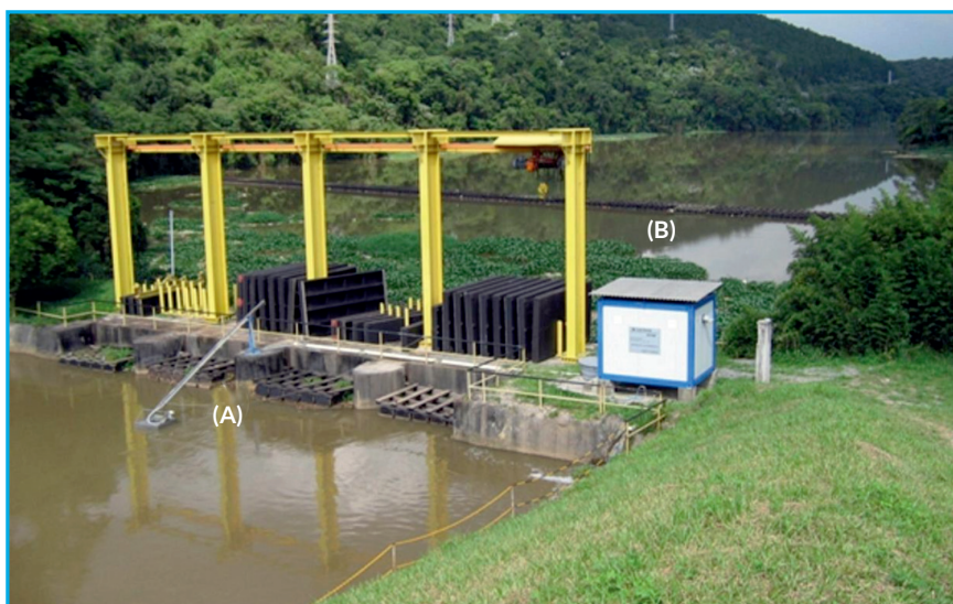
Figura 90. Vista da Estação Automática de Monitoramento Rasgão, localizada no rio Tietê em Pirapora do Bom Jesus - SP: (A) Vista da estrutura metálica flutuante que suporta a bomba de recalque; (B) Container (Foto: Luis Altivo Carvalho Alvim/CETESB).
