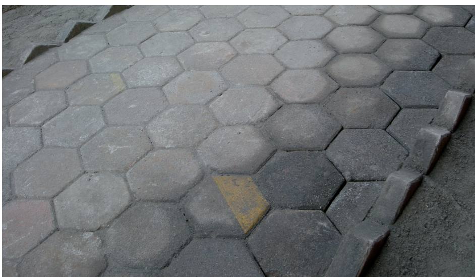
Aproveitamento de bloquetes de demolição da edificação anterior como pavimentação do novo empreendimento
