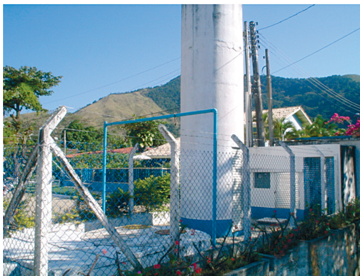
Figura 4: Chaminé de equilíbrio da EPC do emissário das Cigarras.
