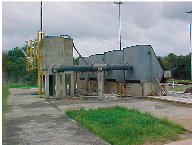
Figura 2: Caixa de areia e peneiras estáticas da EPC do emissário do Araçá.
