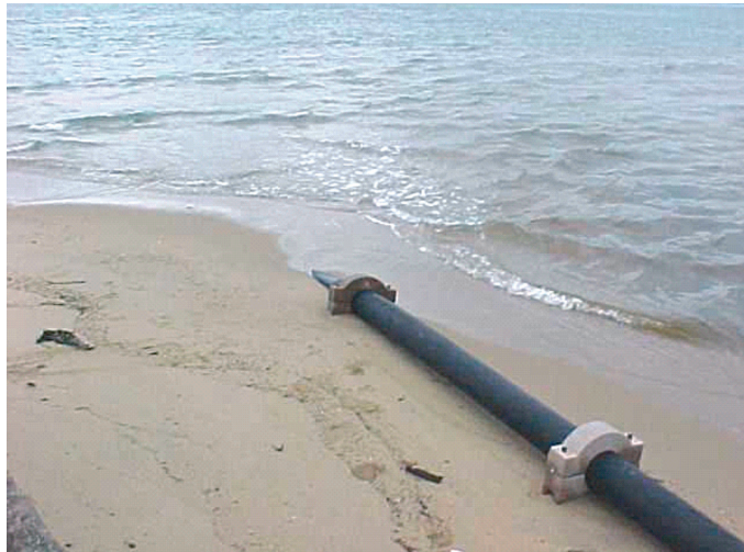
Figura 5: Tubulação de PEAD do emissário submarino do Saco da Capela com os lastros de concreto na transição terra-mar.
