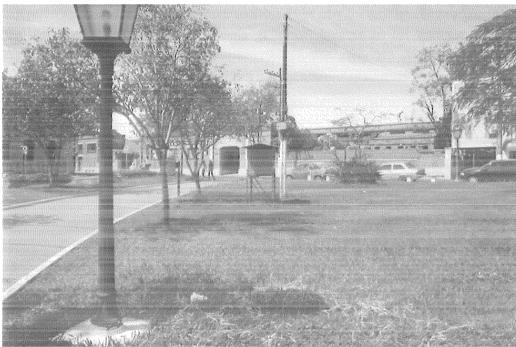
Figura 4 – Vista da estação Itu – Face Sul
