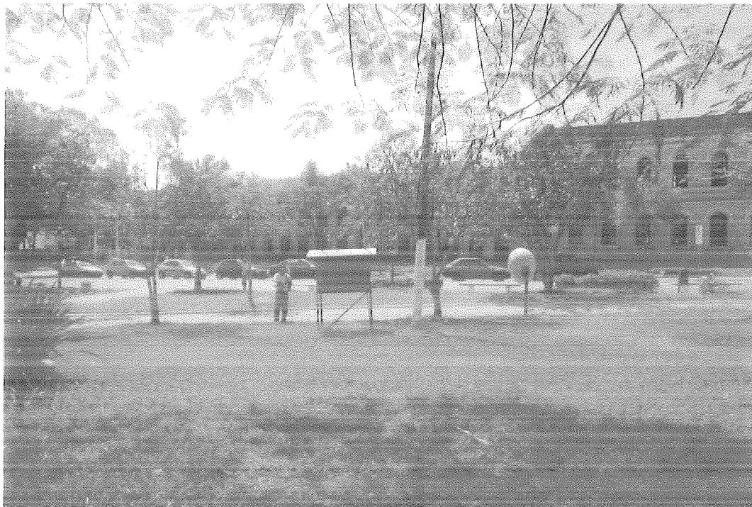
Figura 5– Vista da estação Itu – Face Leste
