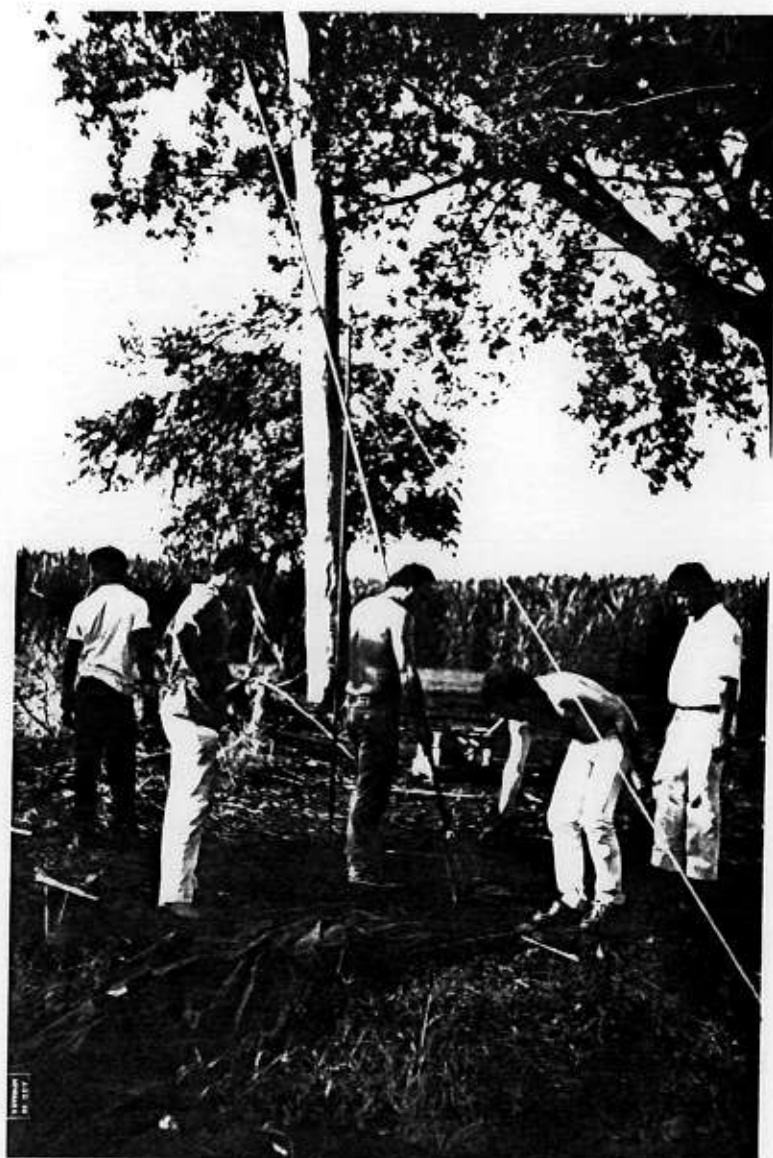
FOTO 3 - Retirada do solo amostrado para coleta de amostra.
