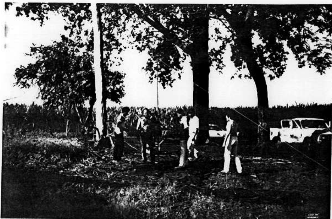
FOTO 1 - Trado Mecânico em operação. Os dois operários forçam o trado para baixo para conseguir o avanço da sondagem.
