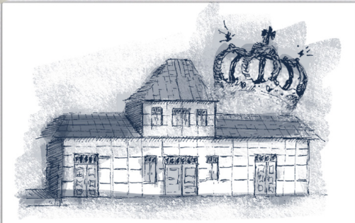
A Estação Ferroviária foi inaugurada em 1888 para a Companhia Estrada de Ferro de Bananal
