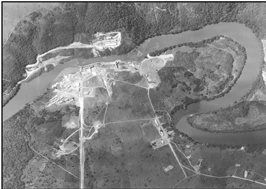
Figura 1.2 – Foto da construção da barragem de Jurumirim em 1959 (Duke 2016).
