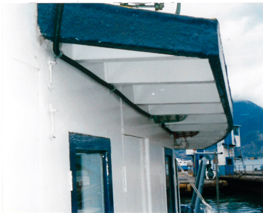
Ampliação da Rede de Auto-falantes para o convés embarcação
