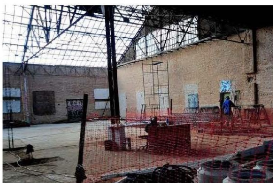
Operário trabalha dentro do prédio - EMÍDIO MARQUES
