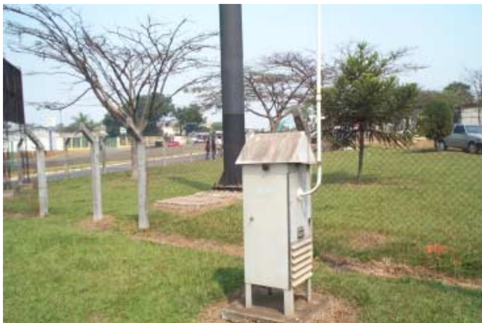
Figura 10 – Vista leste da estação Limeira-Ceset
