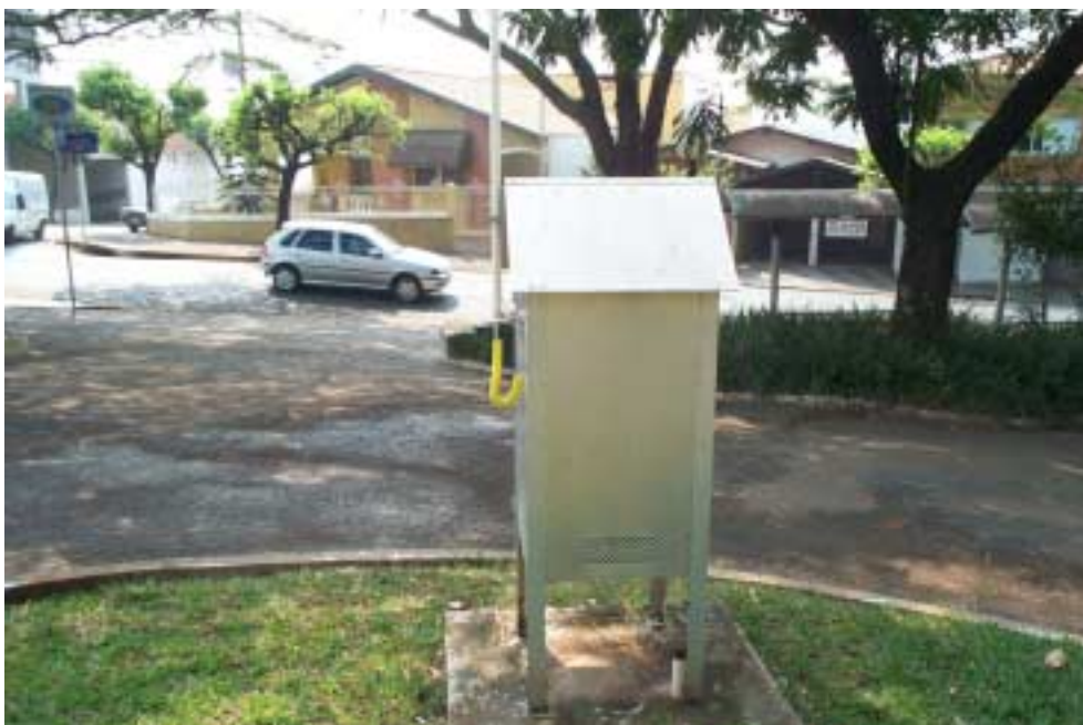
Figura 6 – Vista oeste da estação Limeira-Centro
