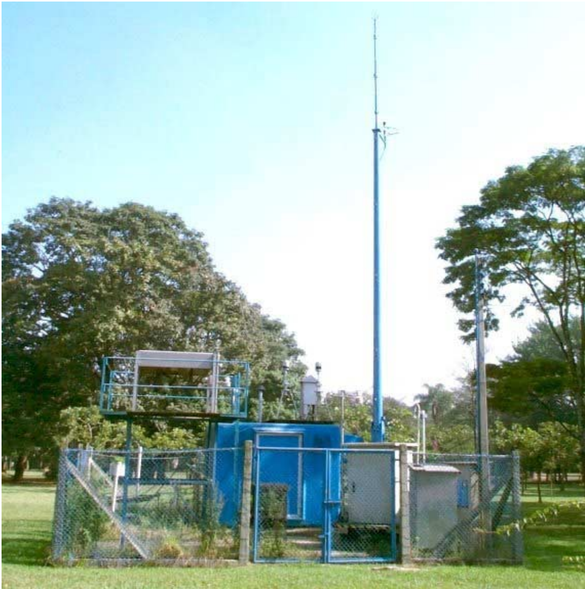
Figura 5 - Vista da estação Ibirapuera
