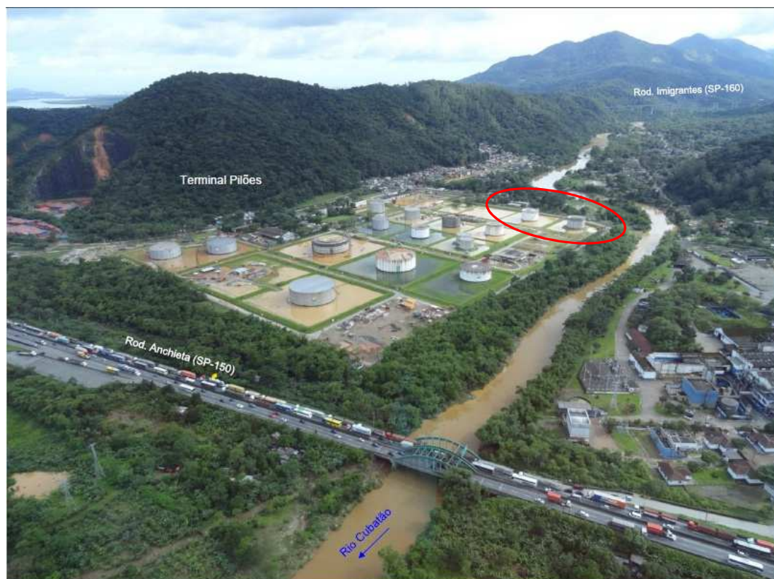
Figura 2 – Terminal Pilões da Transpetro em Cubatão (SP) em 23.02.2013. No destaque, os tanques TQ-14011 (à direita) e TQ-14023, com lâmina d’água visível no interior das bacias de contenção
