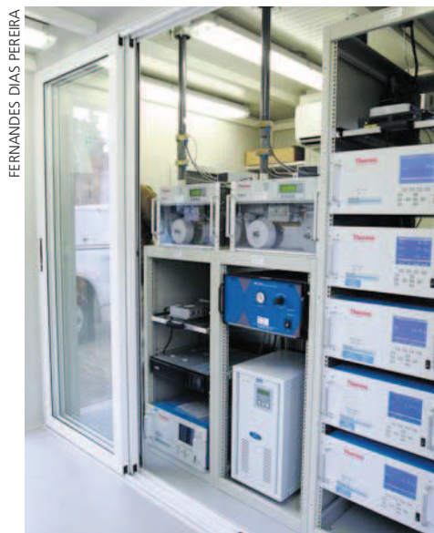
Estação – Parte do circuito de visitação
